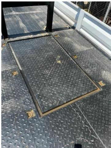
Deverão ser instalados reforços sob o piso para garantir a sua durabilidade e resistência mecânica e travessas com distanciamento máximo de 600mm.
